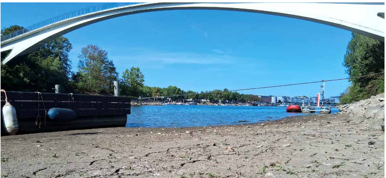
Historische tiefe Pegelstände erfordern Anpassungen in der Wasserrettung.
